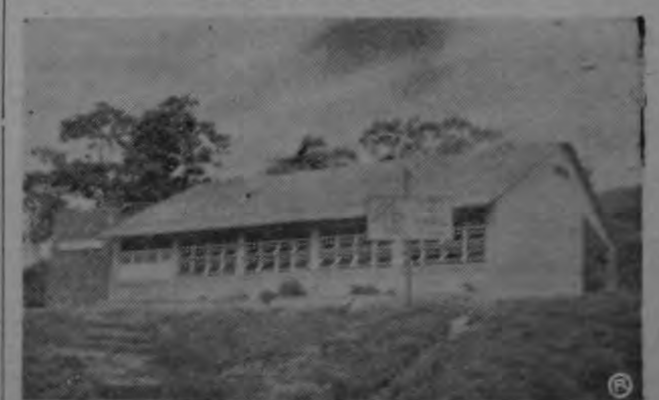
ESCUELA DE DESMONTE DE SAN MATEO.— Local escolar en la provincia de Alajuela, construido por el Ministerio de Obras Públicas con una erogación de $89.252. Esta moderna escuela consta de 3 aulas, Dirección, servicios sanitarios y amplio corredor. Es de una estructura de metal y fue construida de ladrillo mixto. Vino a llenar una de las más imperiosas necesidades de la localidad o sea, la docencia de sus niños.
